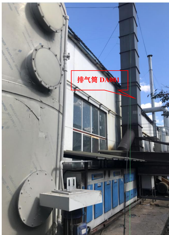
水喷淋+过滤棉+光催化氧化+活性炭吸附+DA001 排气筒
